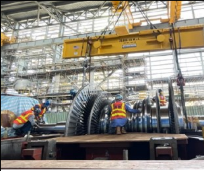
#8 ST 低壓汽機(A)轉子最終安裝
