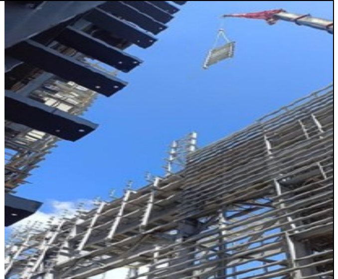
#8 氣渦輪機廠房西側圍樑安裝
