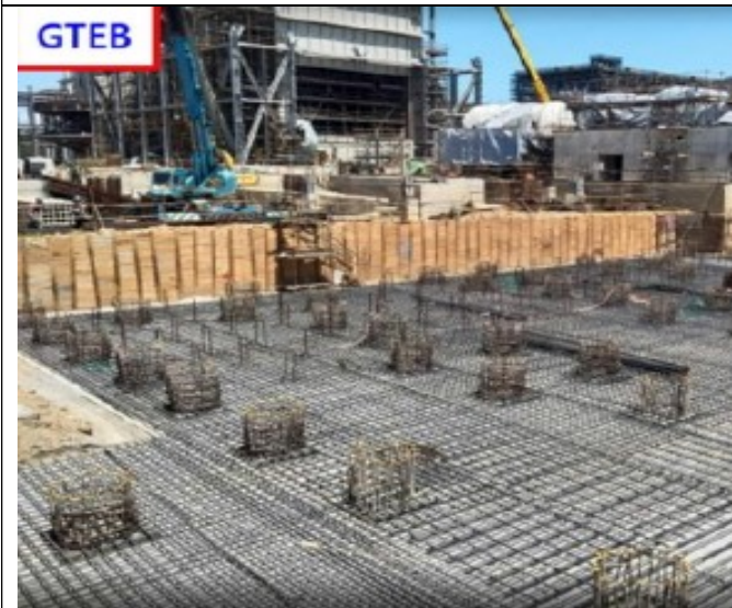
#9 氣渦輪機電氣大樓基礎補強鋼筋組立
