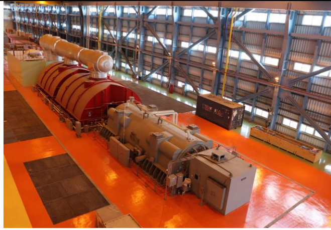
大林計畫 2號汽機廠房
