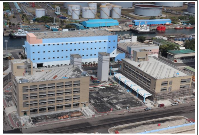
大林計畫 修配工廠施工現況
