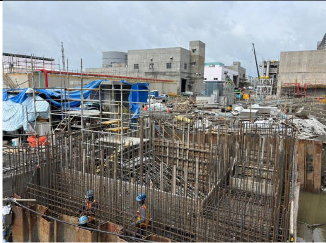
主發電設備工程 Unit 3 GT 廠房 結構體
