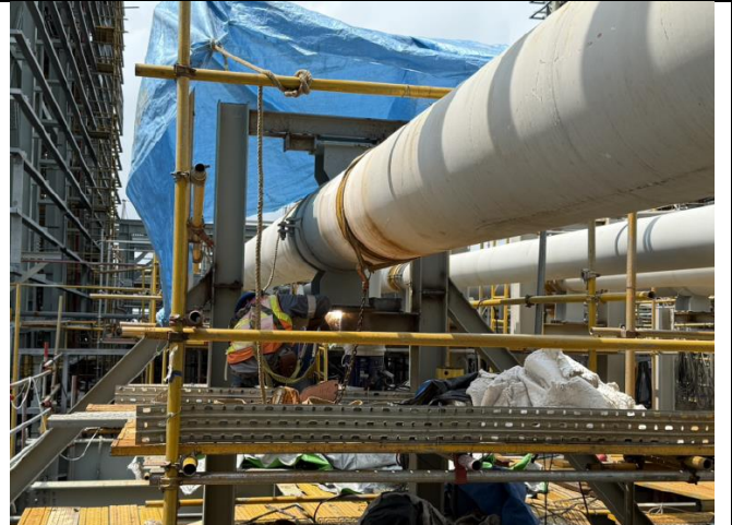
主發電設備工程 Unit 3 MPR 配管
