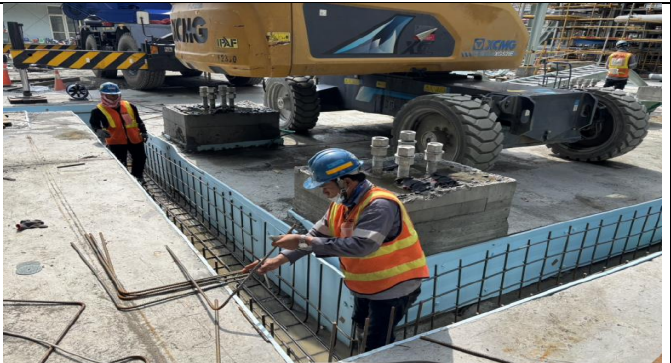
主發電設備工程 Unit 3 HRSG 3-2 結構體
