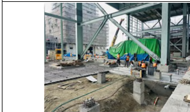
主發電設備工程 Unit 3 GT 廠房 結構體
