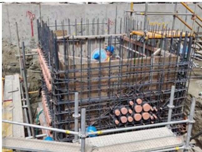
主發電設備工程 Unit 3 ST 廠房 結構體
