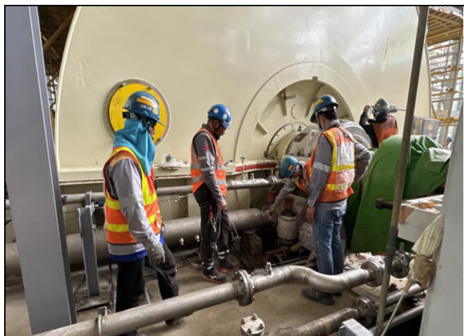
主發電設備工程 Unit 2 ST 設備安裝
