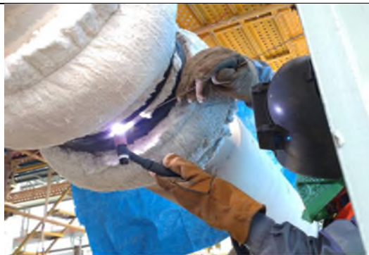
主發電設備工程 Unit 3 MPR 配管
