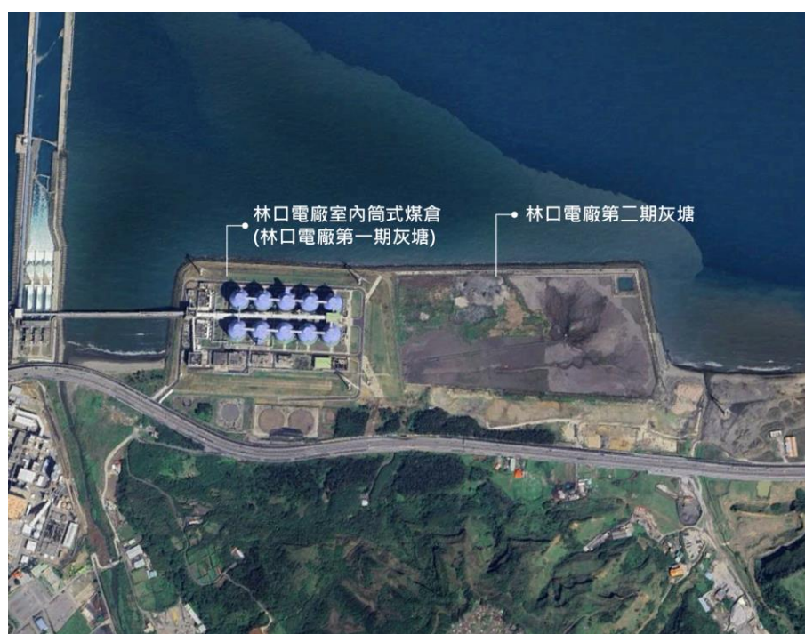
圖 3-5 林口電廠二期工程填地場址
