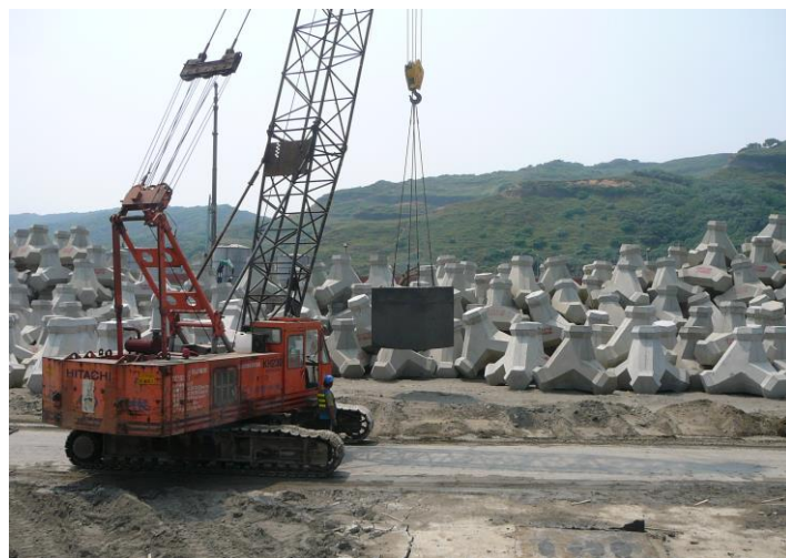
圖 3-19 全煤灰 CLSM 預鑄方塊現場試吊情形(澆置後 14 天) [26]
