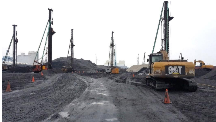
圖 3-7 擠壓砂樁施工情形 [24]
