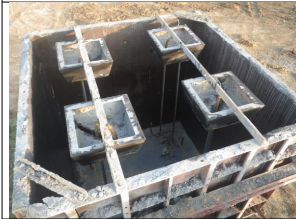
(c) 預埋吊筋組立固定
