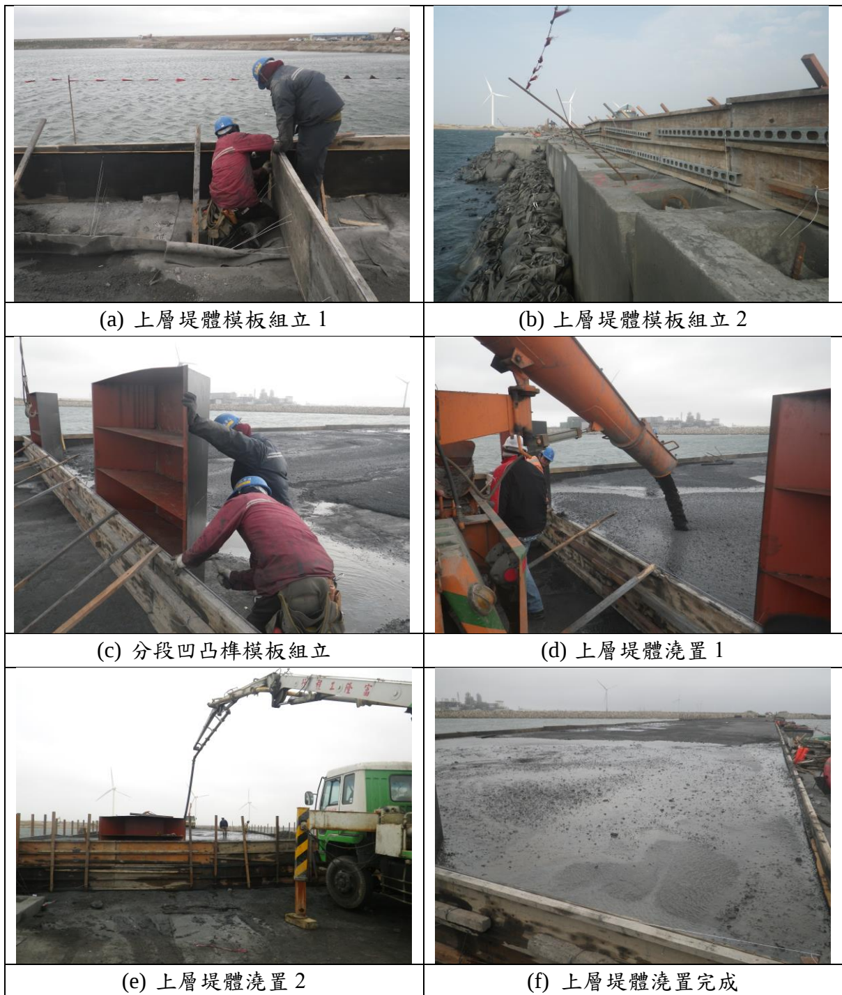
圖 3-23 東隔堤上堤體澆置 [26]
