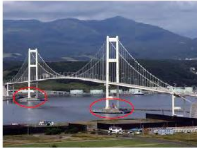
圖 3-43 Hakuchou-Oohashi 大橋橋墩臨時圍堰之施作完成圖 [3]
