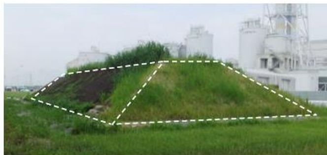
圖 3-41 Shinchī 電廠海堤完成圖 [3]
