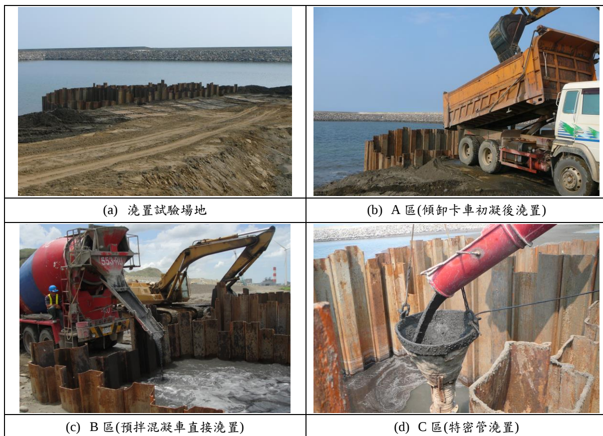
圖 3-16 現場澆置情形 [26, 29]
