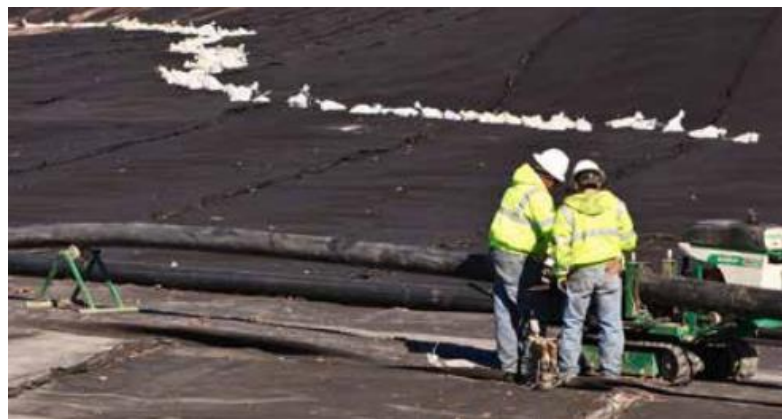
圖 3-51 Asheville 區域機場道路鋪設工程 [39, 40]
