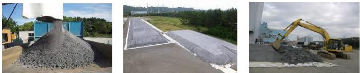
圖 3-49 日本福島縣盤城市港區臨時道路煤灰混和材料現場製作情形 [2]
