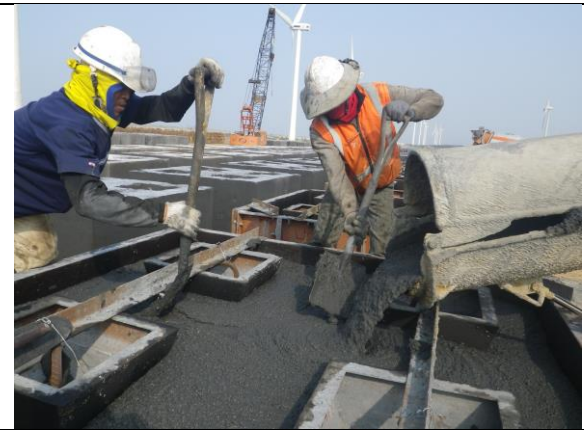
(d) 全煤灰 CLSM 澆置
