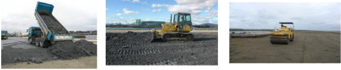
圖 3-50 日本福島縣盤城市港區臨時道路臨時道路之現場施工情形 [2]
