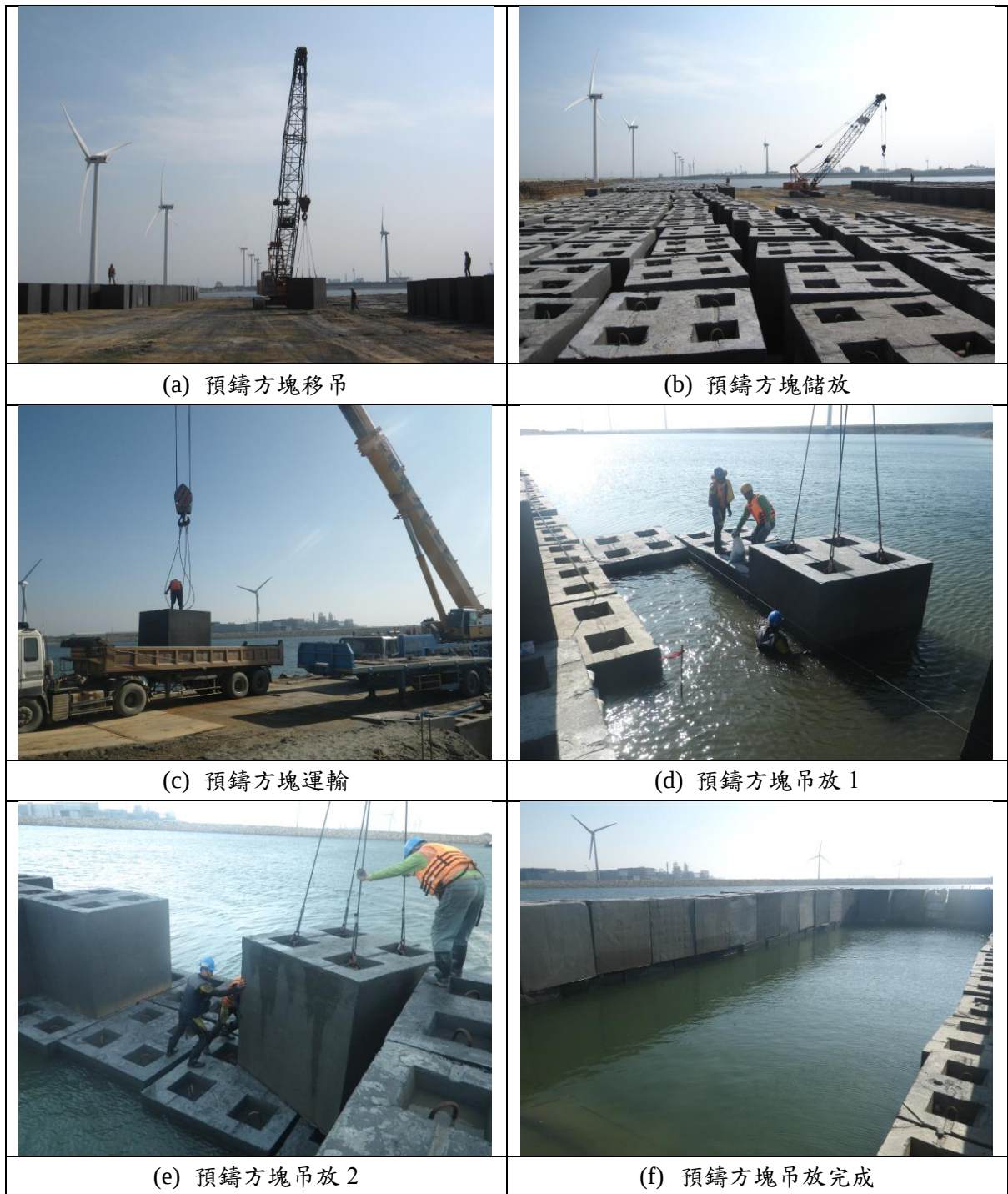
圖 3-21 全煤灰 CLSM 預鑄方塊澆置及吊放施工過程(2/2) [26]
