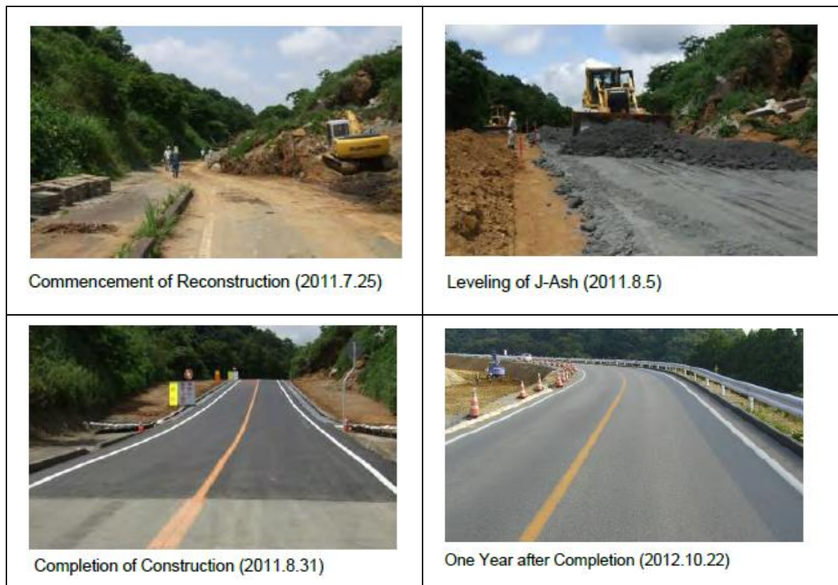
圖 3-48 日本福島縣石川線臨時道路施工及完成圖 [3]
