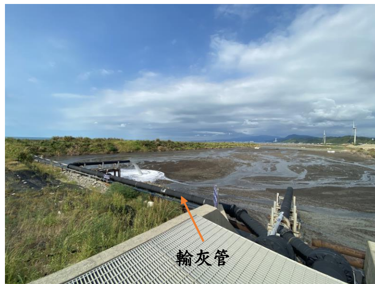
圖 3-1 林口電廠排灰情形(台電內部資料)
