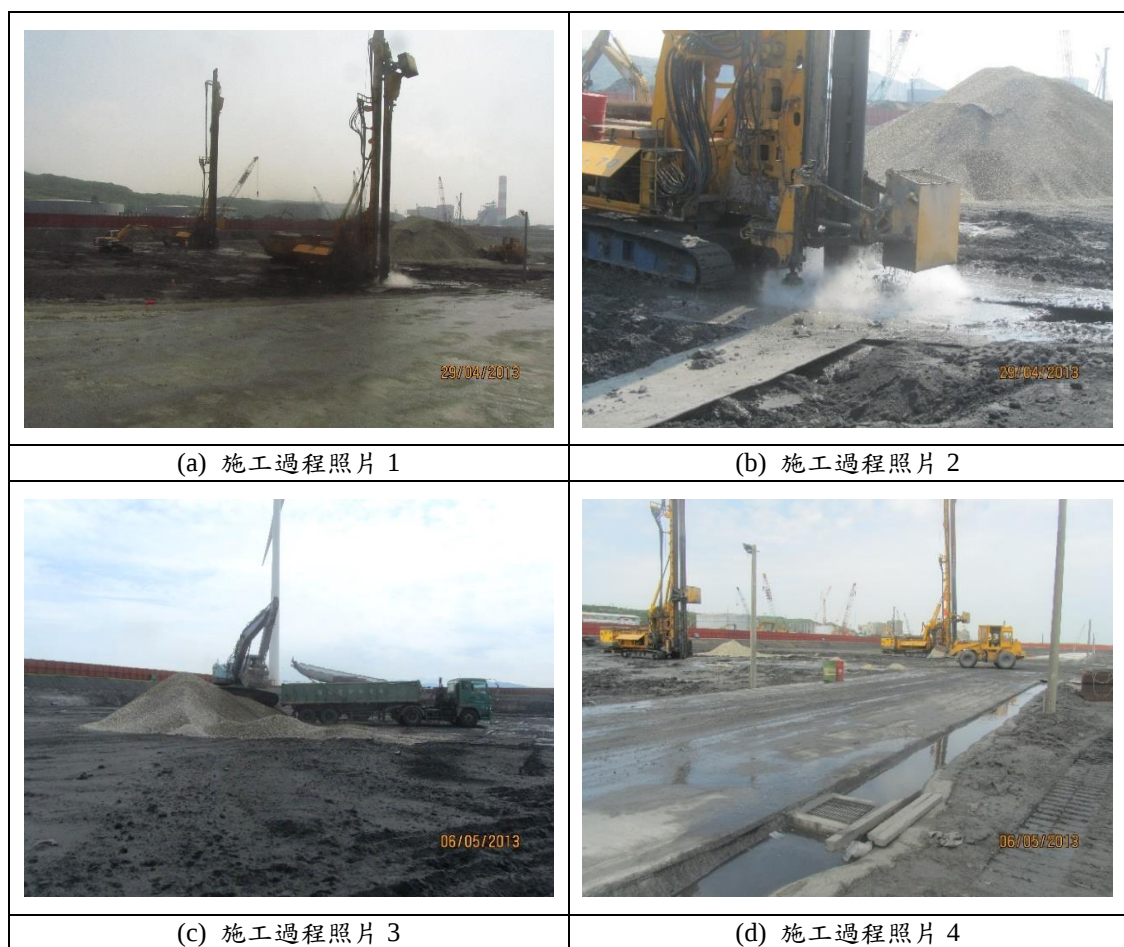
圖 3-2 礫石樁施工情形(台電內部資料)
