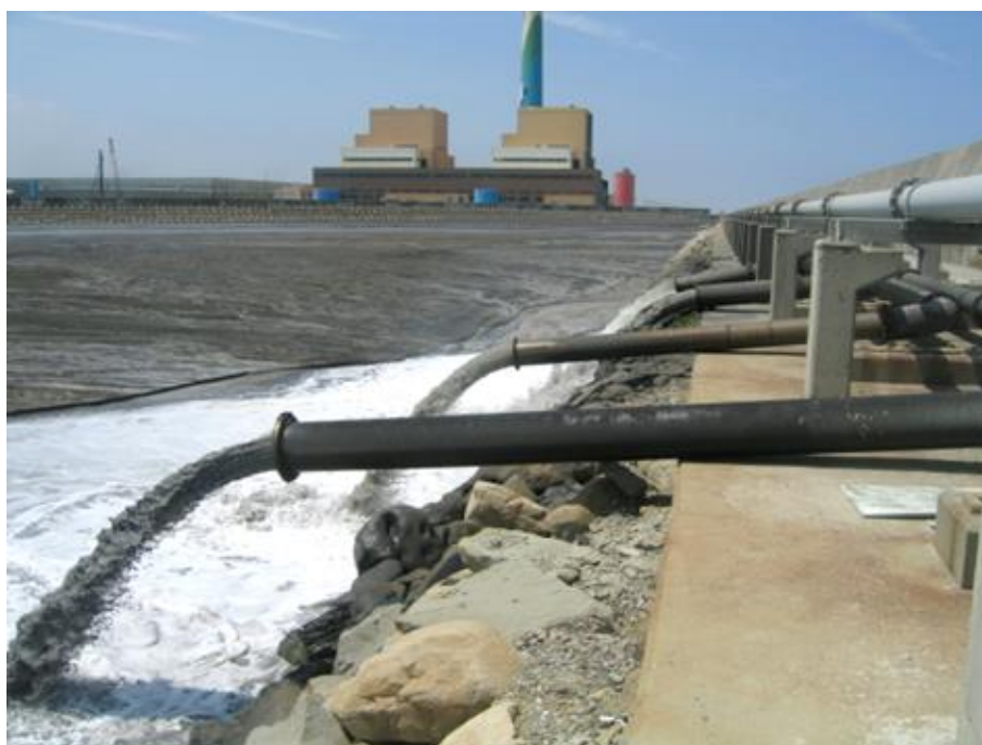
圖 3-6 台中電廠一期工程填地排灰情況(台電內部資料)
