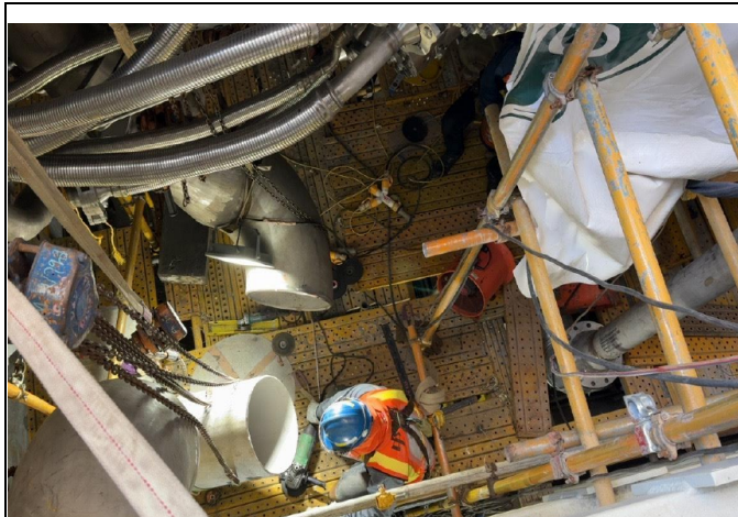
主發電設備工程 Unit 3 GT 設備安裝
