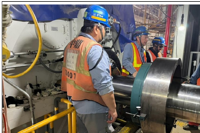
主發電設備工程 設備安裝
