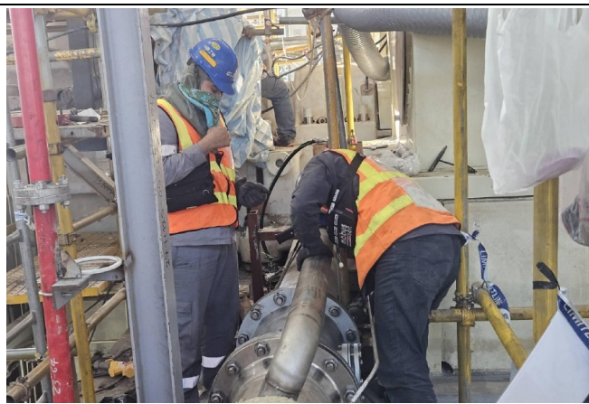
主發電設備工程 設備安裝
