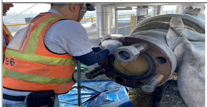
主發電設備工程 設備安裝
