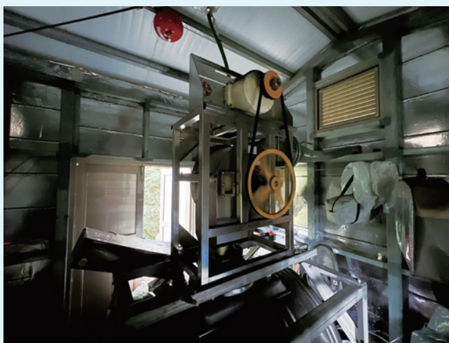
檜谷山莊水力發電機，屬於直接衝擊式水車，以大齒輪帶動上方小齒輪的發電機增速發電。
