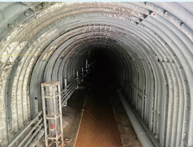
梨山 G1 排水廊道，總長 350 公尺，深入地表下 80 公尺，並於地底下穿越梨山賓館，民國 100 年因應梨山賓館整修開幕，將賓館停車場的 W6 排水井向下開挖 44 公尺，與 G1 排水廊道貫通，讓集水井所蒐集的地下水可藉由廊道排出。有了 W6 集水井增加的水量，使排水廊道出水量可達到穩定的每秒 0.039 立方公尺，再加上 44 公尺的落差，可為絕佳的微水力發電場域，發電完的尾水除了排放到大甲溪供應德基水庫續存外，水保署也配合當地農民所需，設置分水槽提供灌溉取用，善加利用大自然提供的潔淨水資源。
