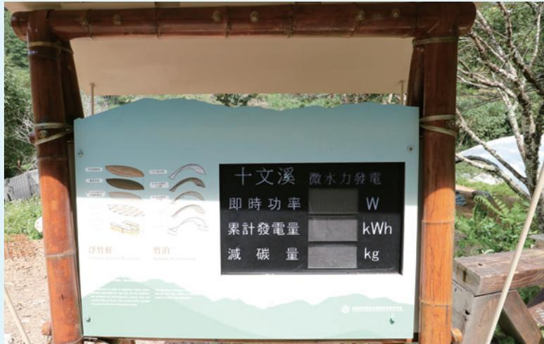
十文溪微水力發電系統電子介紹板，受到強烈颱風凱米侵襲造成進水口淤積，暫時無法進水發電。
