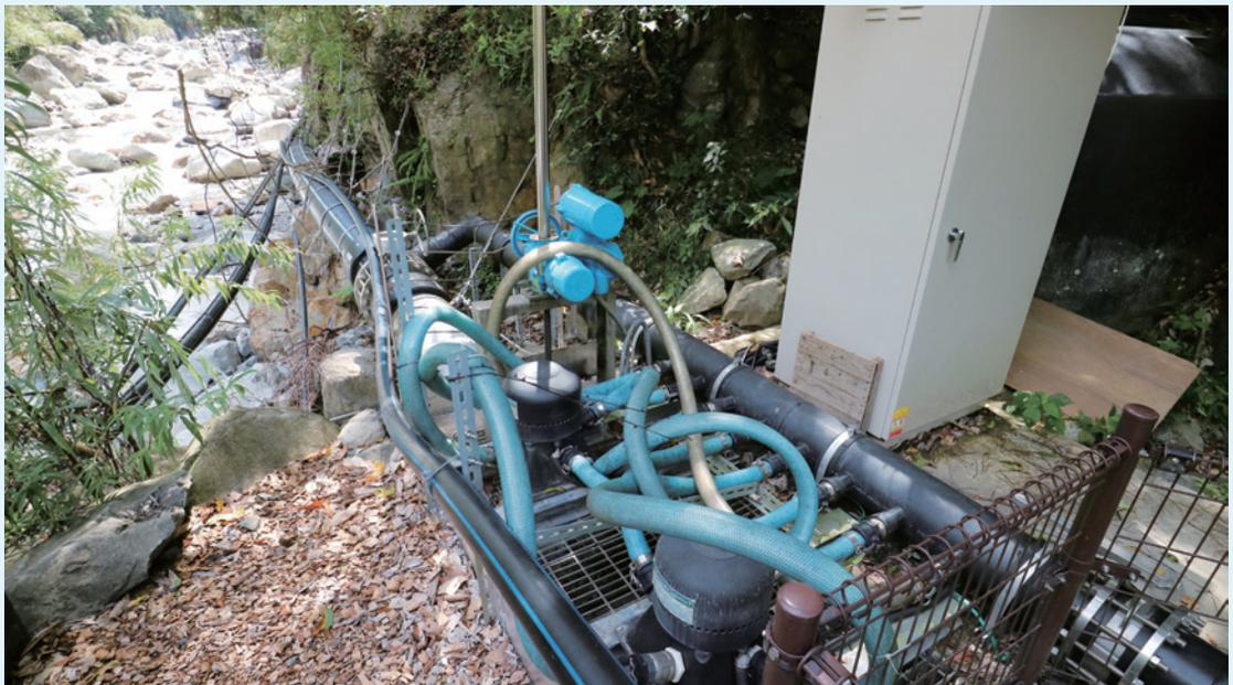
十文溪微水力發電系統的兩部斜沖式水輪發電機，後方機箱為現場控制箱，構造簡單且易維護。
