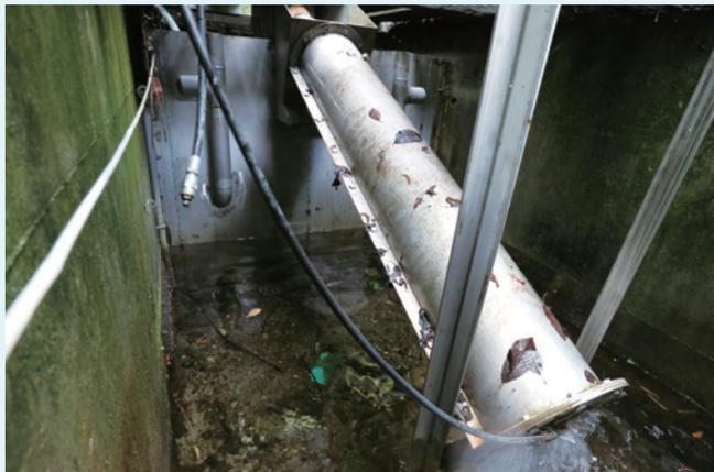
G1 排水廊道第二代微水力發電機組，為 15kW 的阿基米德螺旋式水輪發電機，雖然規模渺小，但供應廊道照明與監測仍綽綽有餘。
