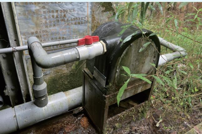
G1 排水廊道第一代沖擊式水輪機，因坑道內運轉聲過大，因此將其移出坑道安裝，但卻也造成能量損失而不足以推動發電，目前為暫時閒置，以第二代機組運轉。
