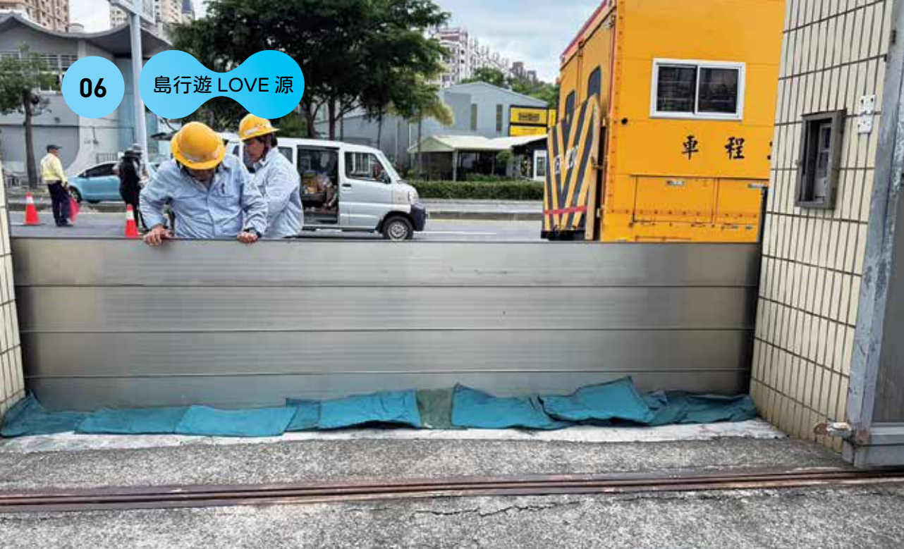
台電高雄區營業處颱風整備，針對民族變電所裝置防水閘門。
