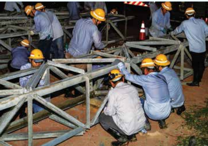
嘉義布袋新塢變電所3座6.9萬伏特高壓電塔遭強風吹倒，台電同仁加速組裝新鐵塔。
