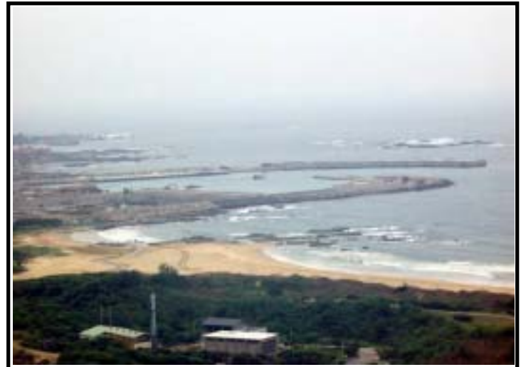
照片 1.1-4 南北防波堤施工現況
