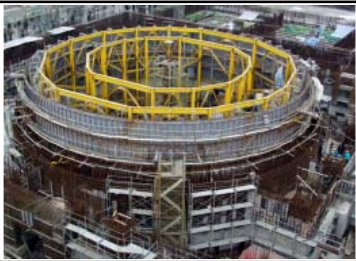
照片 1.1-1 二號機核島區廠房結構施工現況
