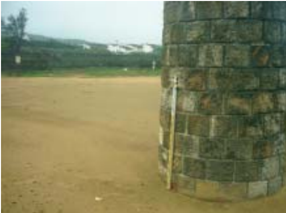
▲ 定位樁一(內河大橋近外海灘線第一橋墩)
