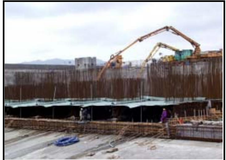
照片 1.1-2 抽水機房施工現況
