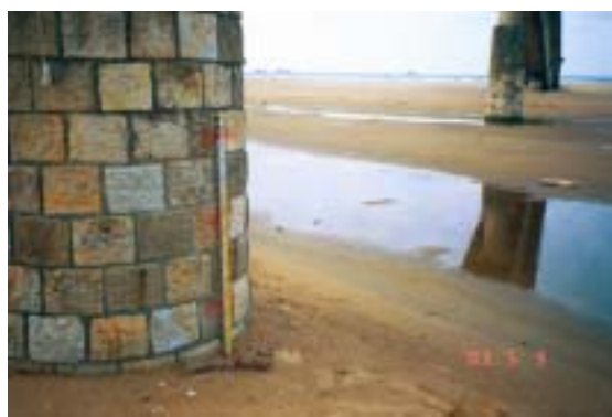
■ 定位樁二(內河大橋近外海灘線第三橋墩)
