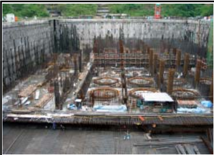
照片 1.1-3 核廢料廠房施工現況
