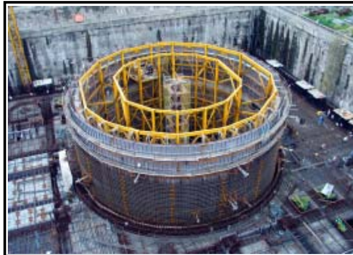
照片 1.1-2 一號機核島區廠房結構施工現況
