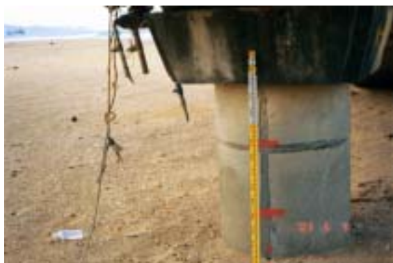
■ 定位樁一(內河大橋近外海灘線第一橋墩)。
