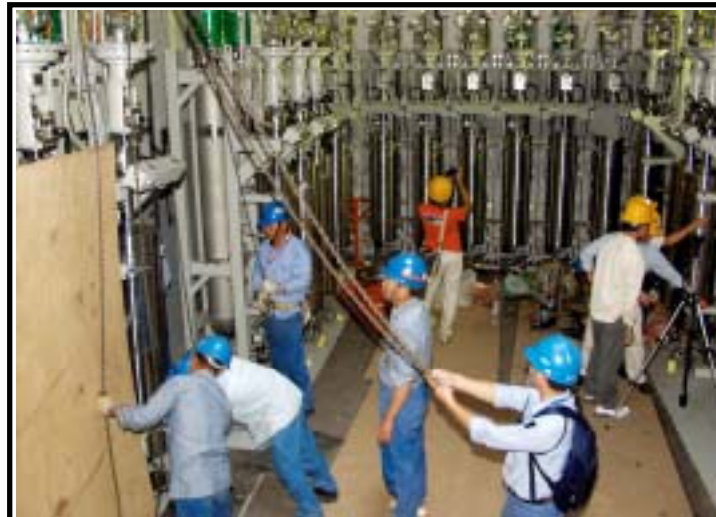
照片 1.1-4 吊裝控制棒液壓控制單元現況
