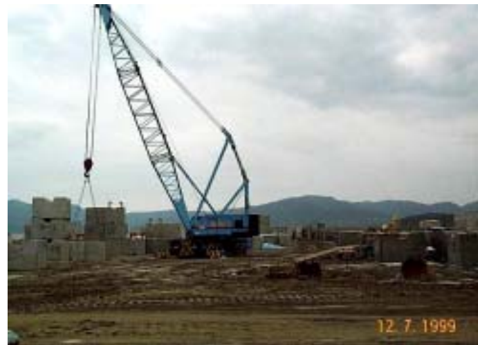
照片 1.1-4 進水口防波堤及重件碼頭工程
