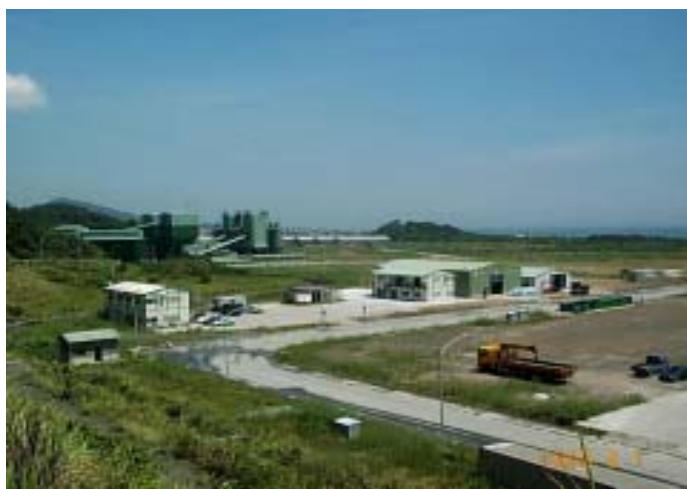
照片 1.1-3 混凝土製造供應工程
