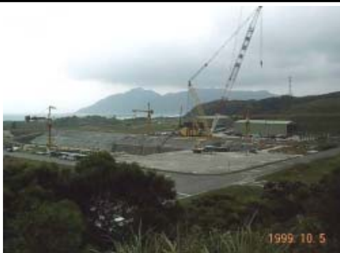
照片 1.1-1 一號機廠房區廠基開挖作業
