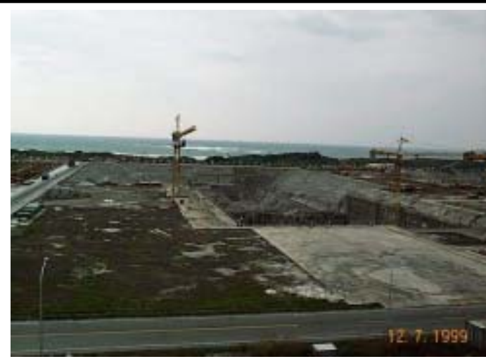
照片 1.1-2 二號機廠房區廠基開挖工程
