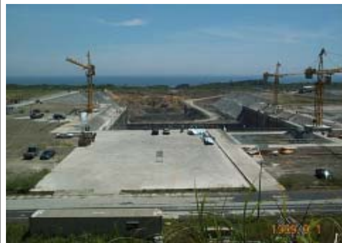
照片 1.1-2 二號機廠房區廠基開挖工程
