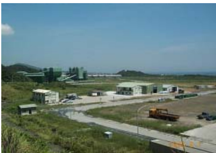
照片 1.1-3 混凝土製造供應工程
