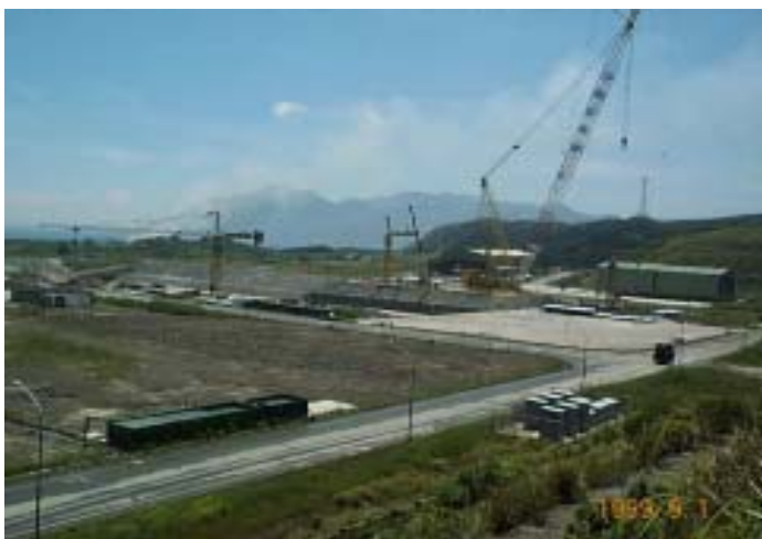
照片 1.1-1 一號機廠房區廠基開挖作業
